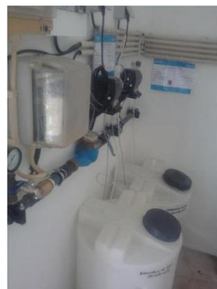
Imagem 9 – Sistema de desinfecção e ajuste de pH
