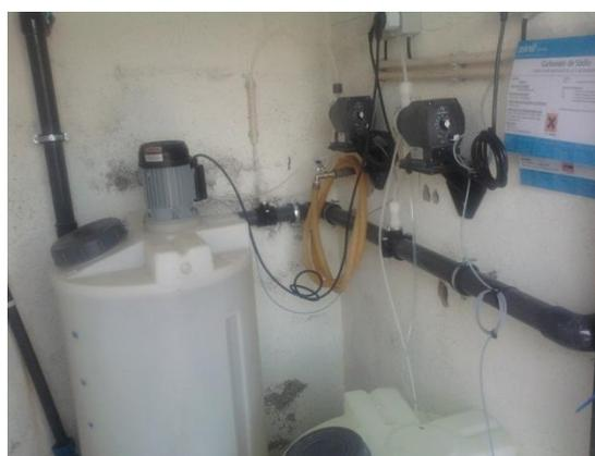
Imagem 7 – Sistema de desinfecção e ajuste de pH
